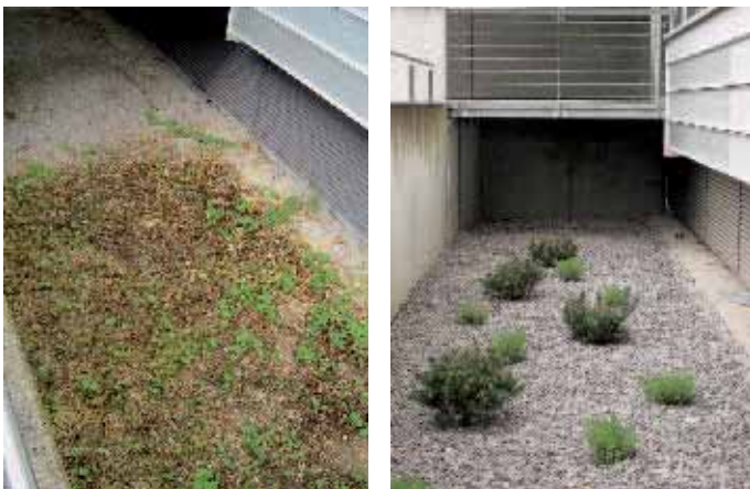
Eingangsbereich der Technikleitstelle Wendlingen-West: Der Pflanzstreifen war früher stark verunkrautet, zudem war der gepflasterte Traufstreifen abgesackt. Der Traufstreifen wurde entfernt und neu errichtet in Beton. Zudem wurde der Pflanzstreifen ausgekoffert, mit einem Schutzvlies versehen und wieder mit Schotter aufgefüllt, damit der Unkrautwuchs vermindert wird.
