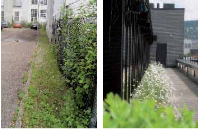
Links: Der Traufstreifen des Kunden- und Technikzentrums in Esslingen war stark verunkrautet und die Pflege der Fläche sehr teuer, weil das Unkraut schnell wieder nachwuchs. Maßnahme: Der Traufstreifen wurde tief ausgegraben, auf die Erde ein Schutzvlies gelegt und mit Schotter verfüllt. Vorteil: Schotter ist gröber als Splitt, daher kann das Unkraut schlechter wurzeln; dank des Schutzvlieses kann es nicht mehr bis zum Boden wurzeln und lässt sich leichter entfernen. Rechts: Die Dachterrasse der ehemaligen Hauptverwaltung in Stuttgart: Statt der Pflanzen auf dem Grünstreifen wuchs früher nur das Unkraut. Maßnahme: Auf dem Substrat wurden Vegetationsmatten ausgelegt und mit Margeriten bepflanzt. Dank der Matten wachsen die Pflanzen.
